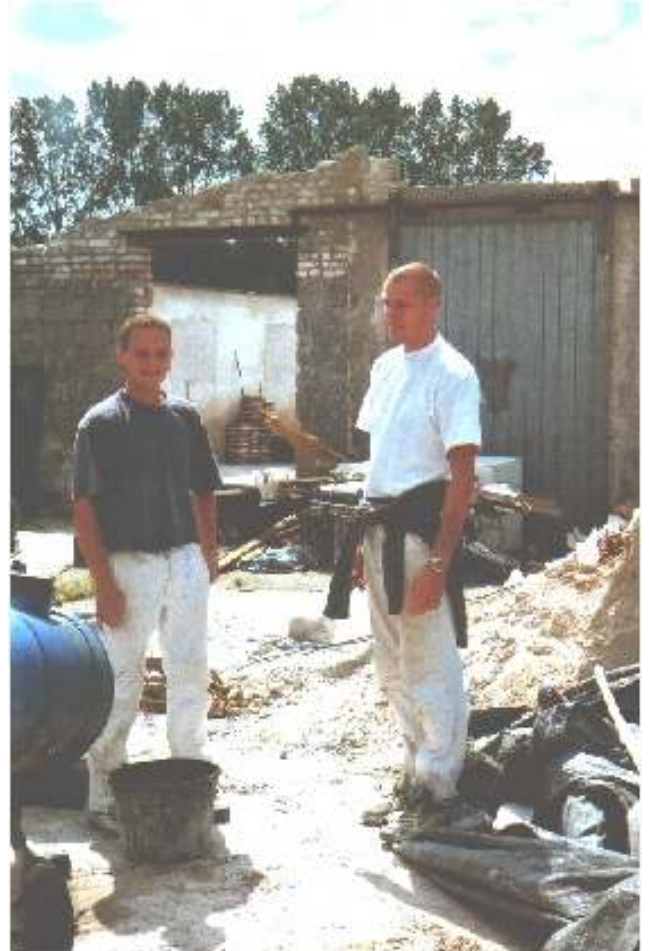
Unsere fleißigen ABM Kräfte Sebastian Pawlik (links) und Marc Salzwedel (rechts) auf der Großbaustelle Hohenbruch.
